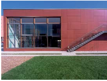
Leuchtend rot setzt der Kubus städtebaulich Akzente. Hell und freundlich sind die Räume.
